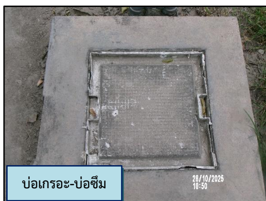
ภาพที่ 2.16 ระบบบำบัดน้ำเสียแบบบ่อเกรอะ-บ่อซึม สำหรับบำบัดน้ำเสียที่มาจากห้องส้วม
