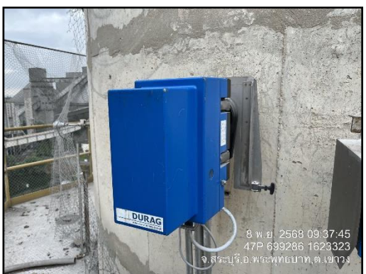
ภาพที่ 2.4 ระบบ Continuous Emission Monitoring (CEMs) หม้อเผาปูนซีเมนต์ขาว 2
