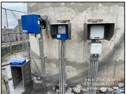
ภาพที่ 2.3 ระบบ Continuous Emission Monitoring (CEMs) หม้อเผาปูนซีเมนต์ขาว 1
