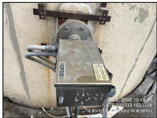
ภาพที่ 2.3 ระบบ Continuous Emission Monitoring (CEMs) หม้อเผาปูนซีเมนต์ขาว 1
